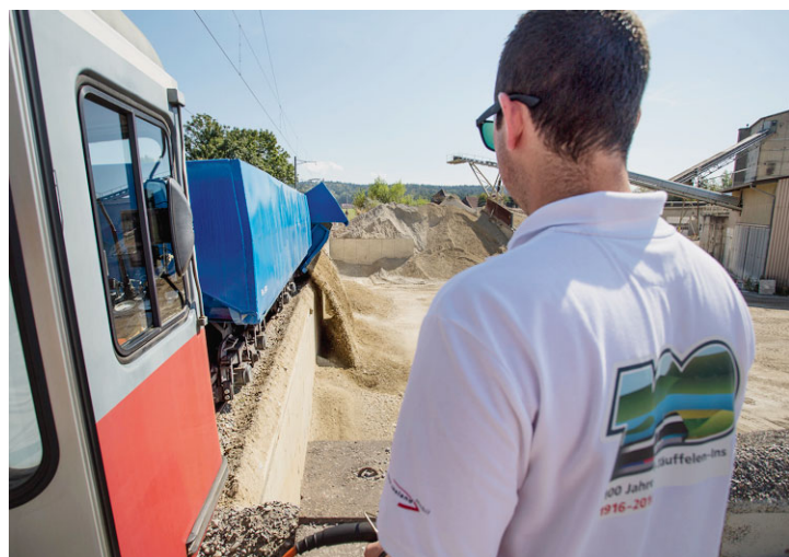
Kies ausladen in Sutz: Eine Angelegenheit von Sekunden. Danach wird Bauschutt geladen und zurück nach Siselen gefahren.
