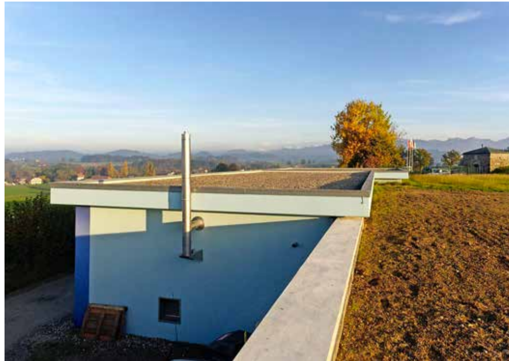
Das bestehende Reservoir wurde erweitert, im Hintergrund das alte Reservoir.
